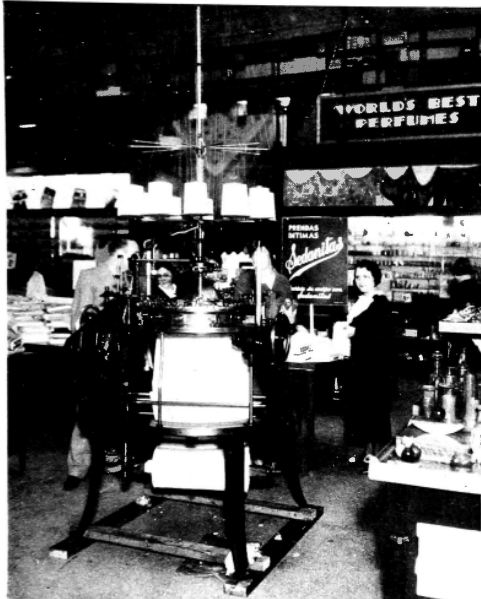
COMO SE FABRICA EL RAYON. —Tejedora automática instalada en un importante establecimiento de esta capital por los fabricantes de "Secantitas", para mostrar al público como se producen los tejidos de rayon. La máquina contiene tres mil agujas, que trabajan simultáneamente.
