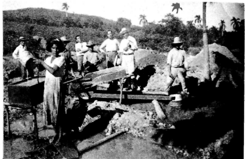
Labores en el arroyo Sucunucum, mina Santiago.
